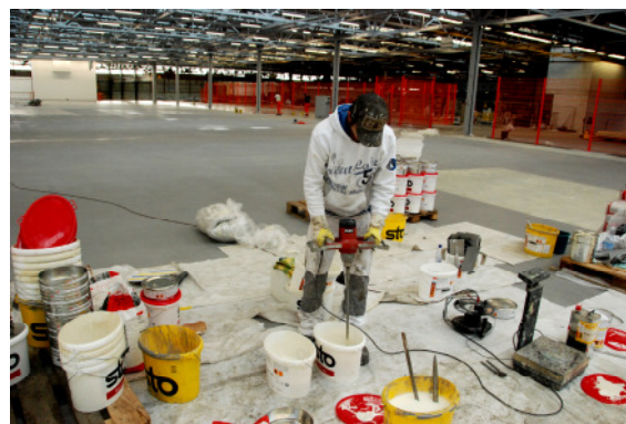
Kevin Wenger mischt die Zwei-komponente Boden-Spachtelmasse
