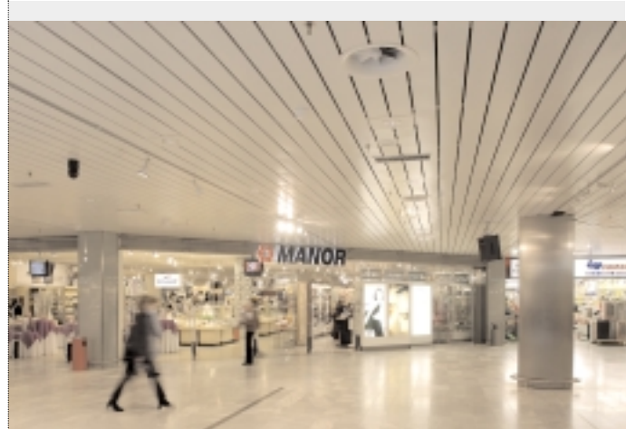
Shopping Center Letzipark in Zürich: Bei laufendem Betrieb in nur 18 Wochen umgebaut.
